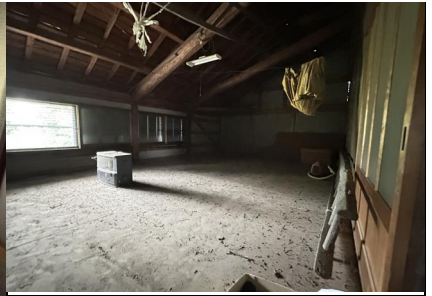
屋根裏収納(2階)
